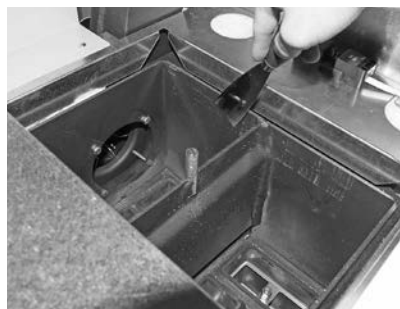
rys. 56 Wyczyścić wymiennik ciepła
