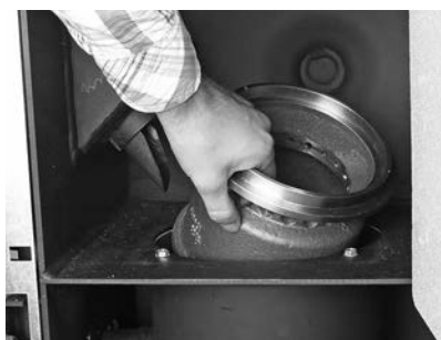
rys.40 Wyjmij dolną część konusa
