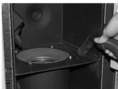
rys.38 Usunąć resztki popiołu i zanieczyszczeń
