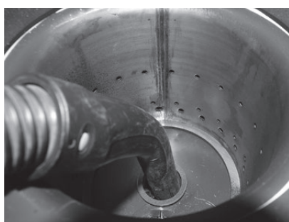
rys. 81 Odkurz rurkę powietrza pierwotnego w środku palnika
