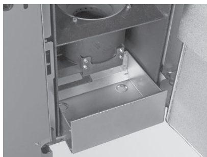
rys. 66 Usuń szufladę 1 na popiół i odtóż ją obok kotła
